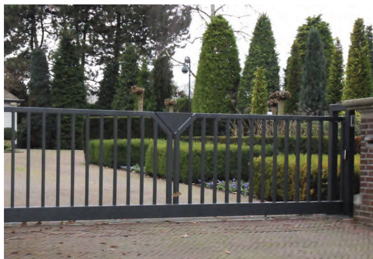
Hekwerk met 'poortautomatisering'
